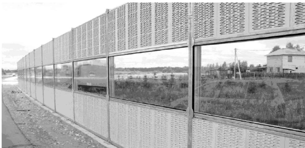
Рис. 1. Акустический экран комбинированного типа
