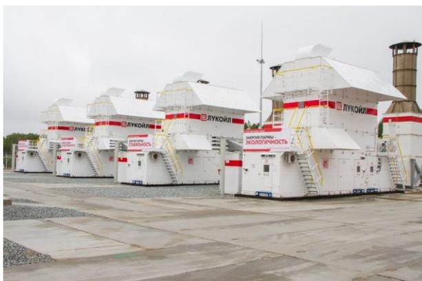
Рисунок 2 – Газотурбинная электростанция в Пермском крае, позволяющая обеспечить утилизацию ПНГ
