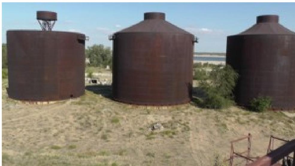
Рисунок 3 – Метантенки, подготовленные в свое время для обработки осадка сточных вод
