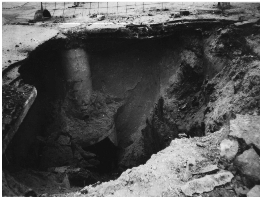
Рис. 1. Развитие суффозионного процесса на контакте грунт – трубопровод
