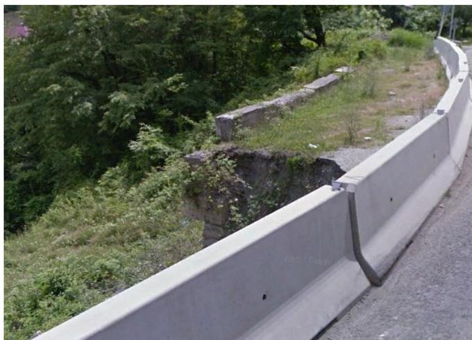
Рисунок 2 — Стенка срыва грунта на исследуемом участке дороги
