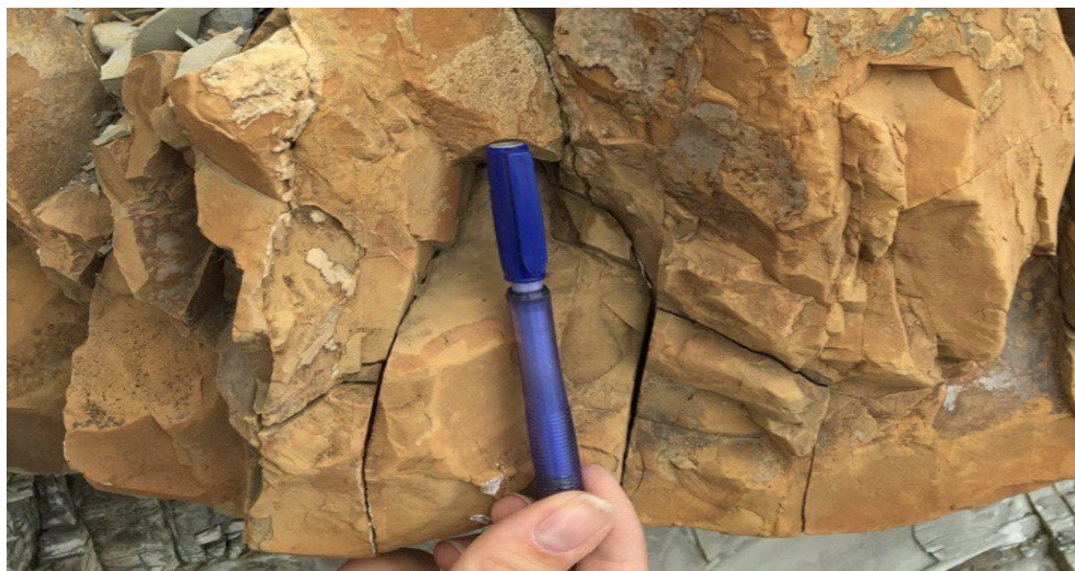
Рис. 7. Трещины, выполненные кальцитом
